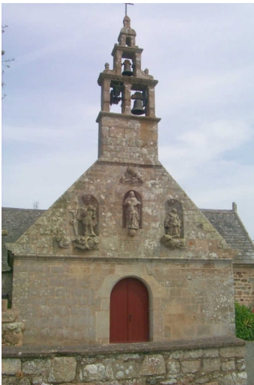
Vue générale, pignon ouest
