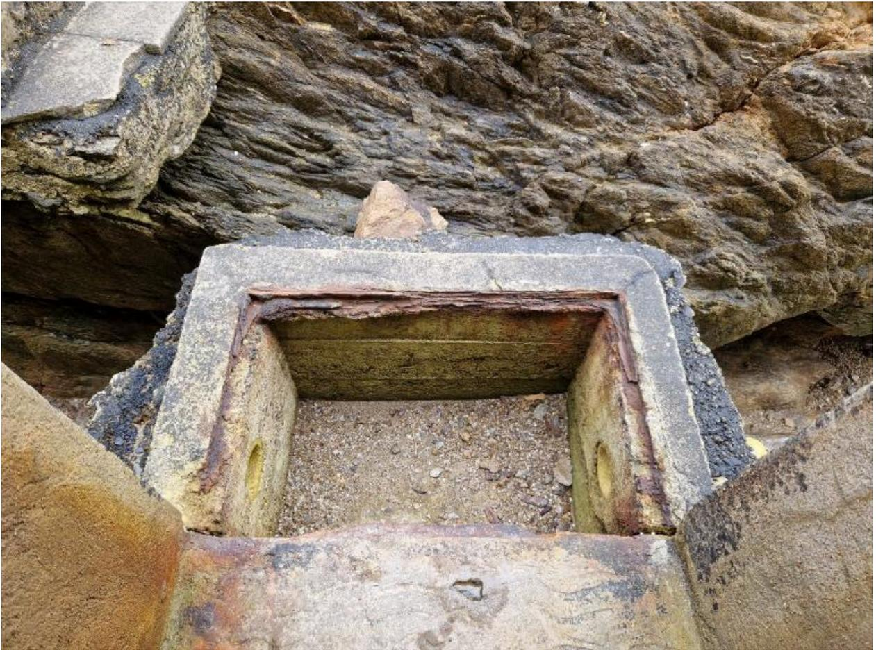
Vue du puisard subsistant devant l'entrée ouest de l'élévation nord. De ce côté, l'érosion marine a emporté le substrat de l'îlot : entrée et puisard sont dans le vide
