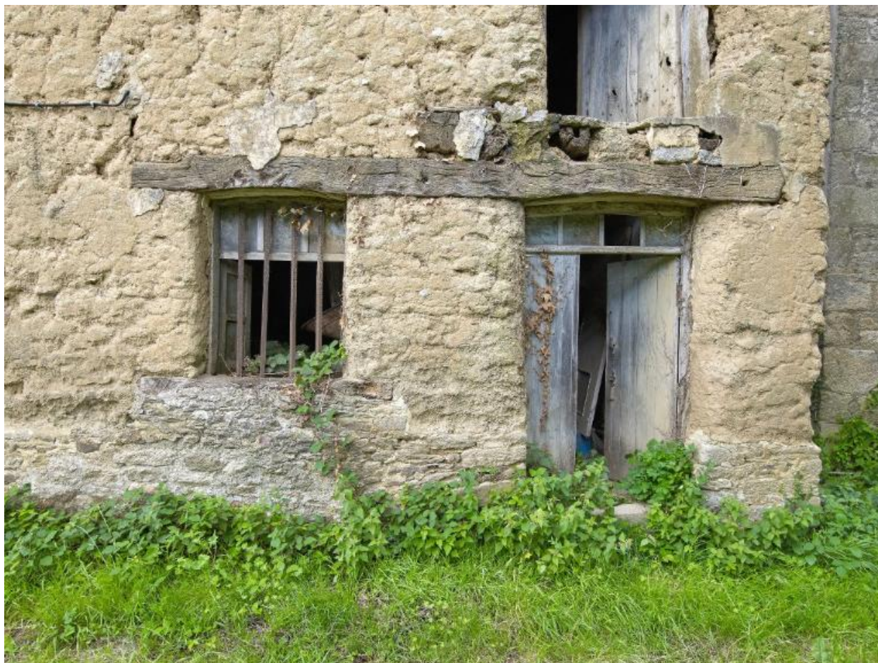
Détail de la façade avec un linteau commun pour les deux ouvertures
