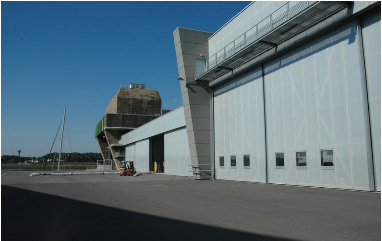
Vue de l'entrée du slipway et des docks reprennant la forme des contreforts en béton armé (2005)
