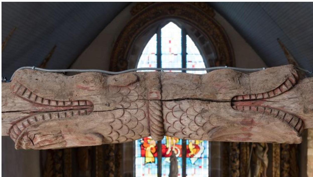
Vue de détail : deux engoulants opposés au centre d'un entrail
