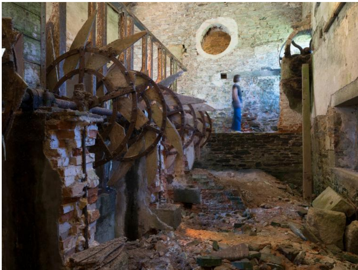
Bâtiment principal. Salle 3. Postes à espader et fosse à étoupe
