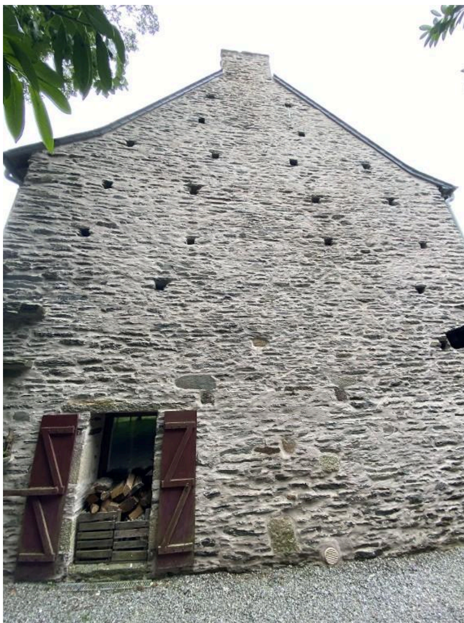
Pignon nord du logis, récemment rénové
