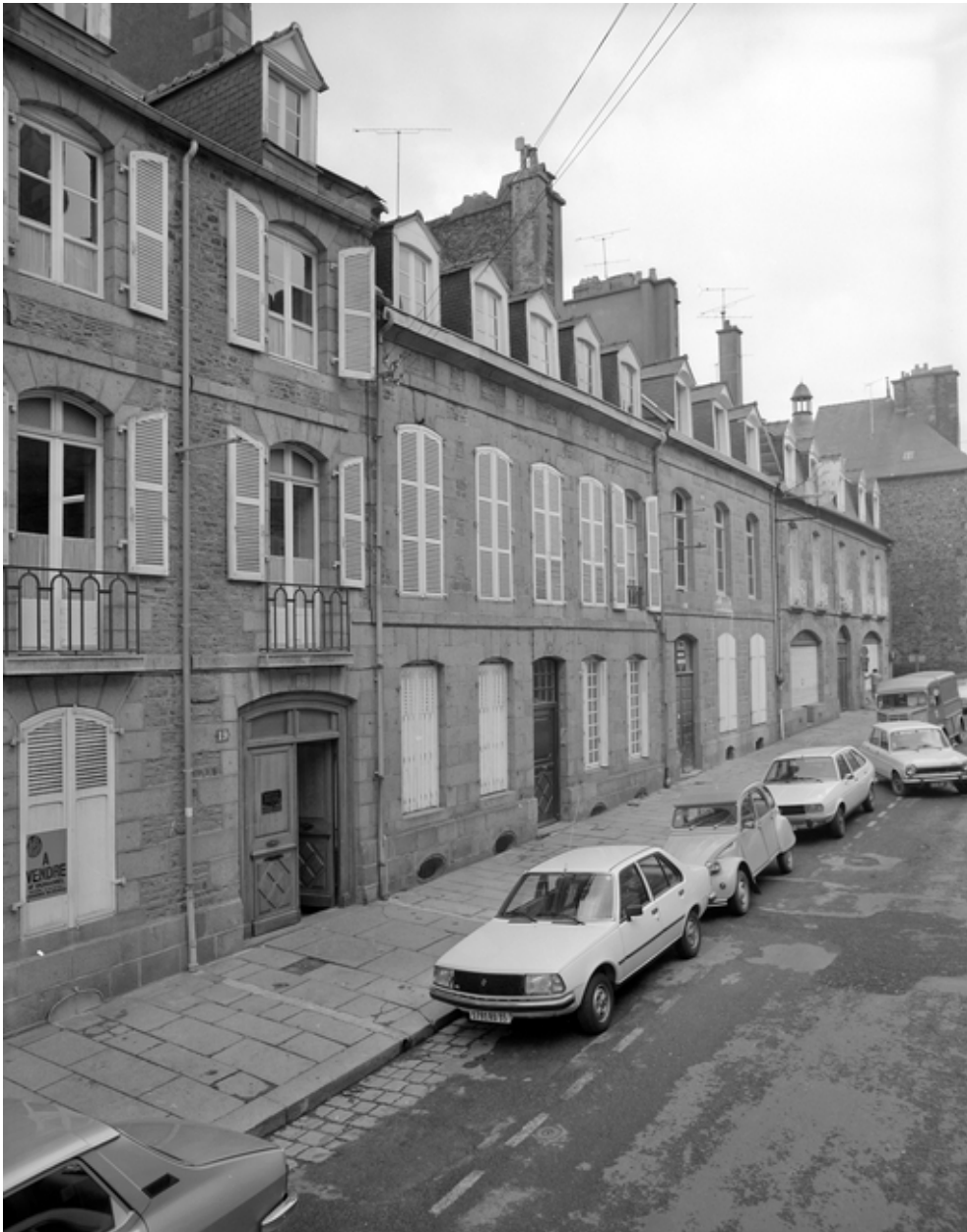
20, 23 et 25 rue Chateaubriand, vue générale nord-ouest.
