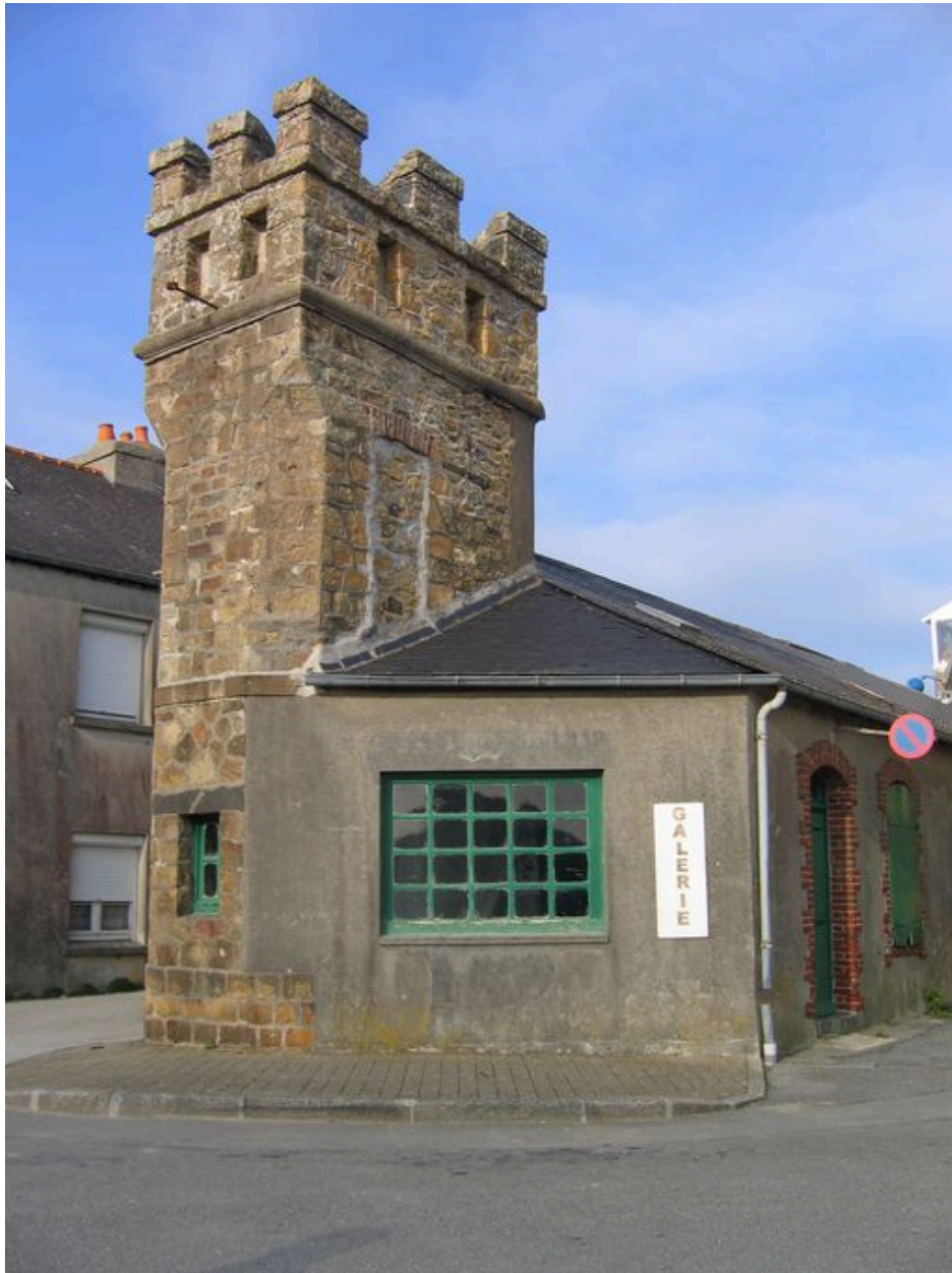
Vue générale de la Tour du Fret
