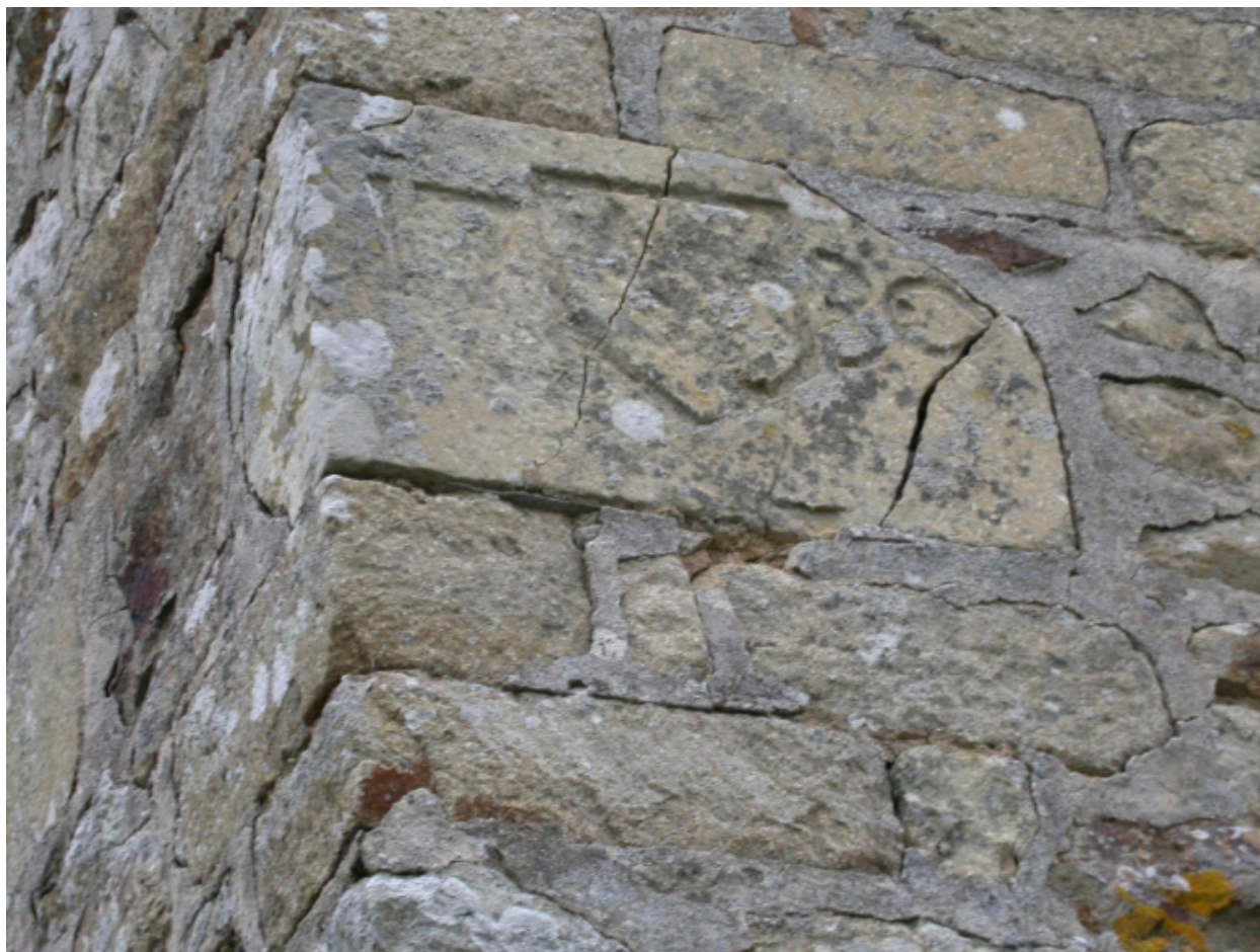
Détail d'une date portée sur l'église
