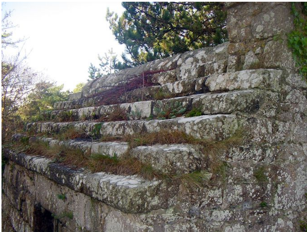
Vue de détail de la couverture en gradin de granite (état avant 2007)
