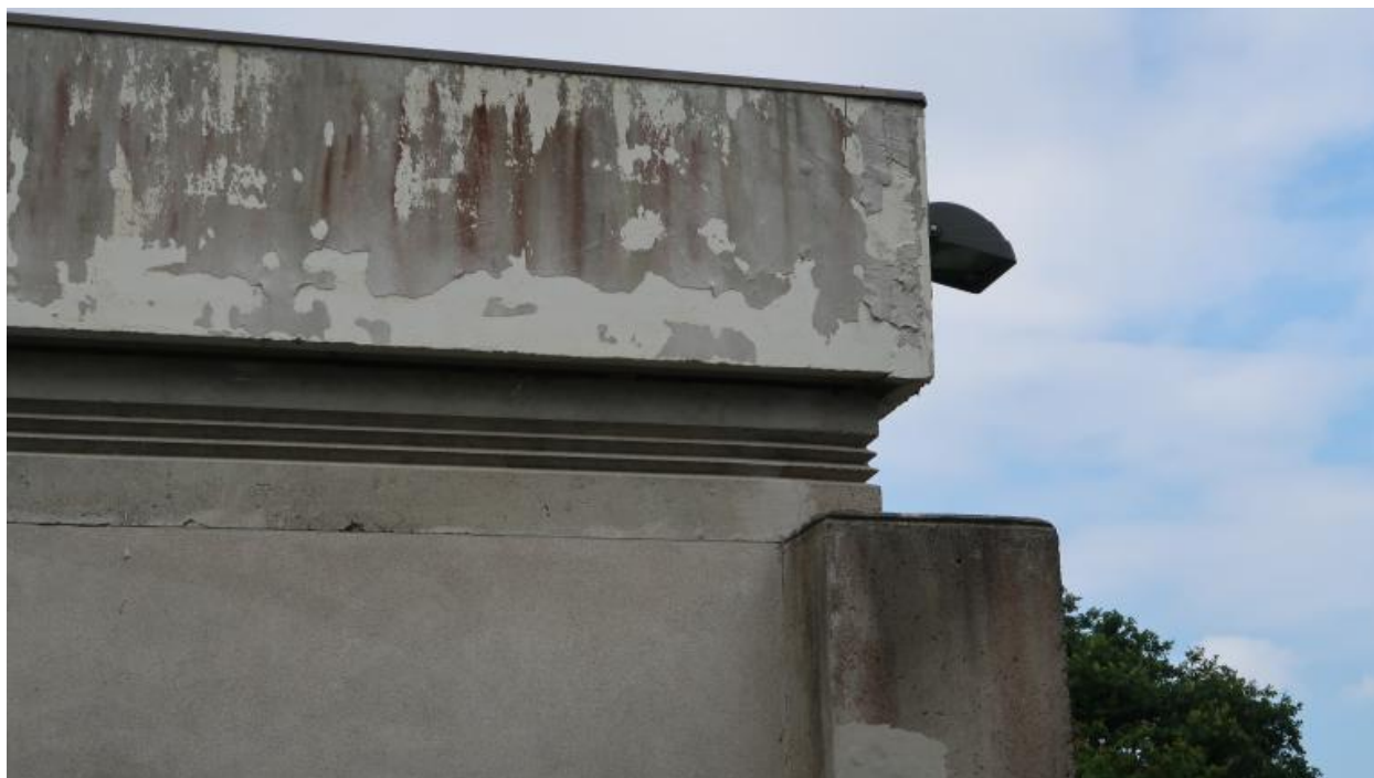
Détail d'une corniche de l'internat, élément important de la modénature.
