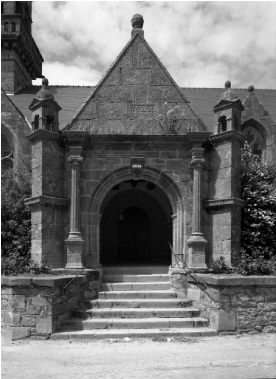
Plomodiern, église paroissiale Saint-Mahouarn : façade sud, porche, état en 1972
