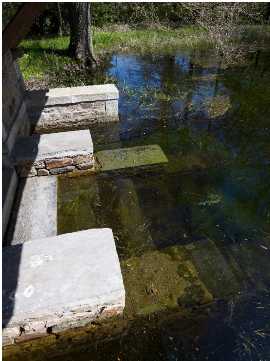
Vue de détail du lavoir
