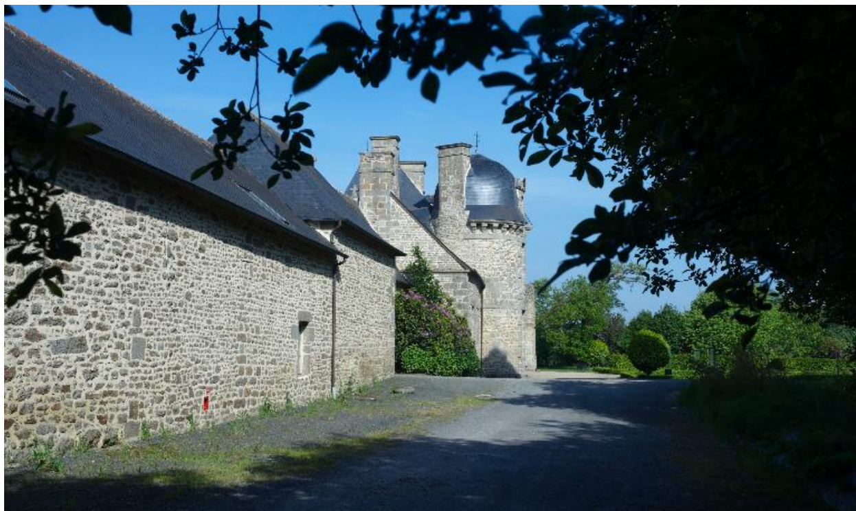
Vue depuis l'ouest
