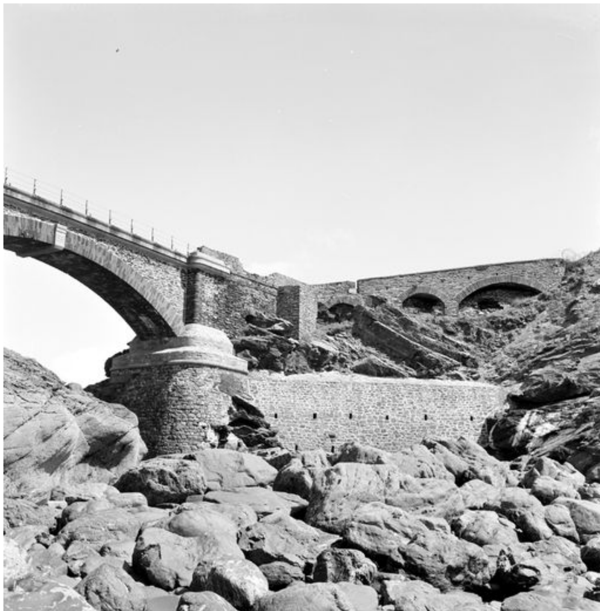
Vue de la pile du pont sud de l'îlot des Capucins en 1969
