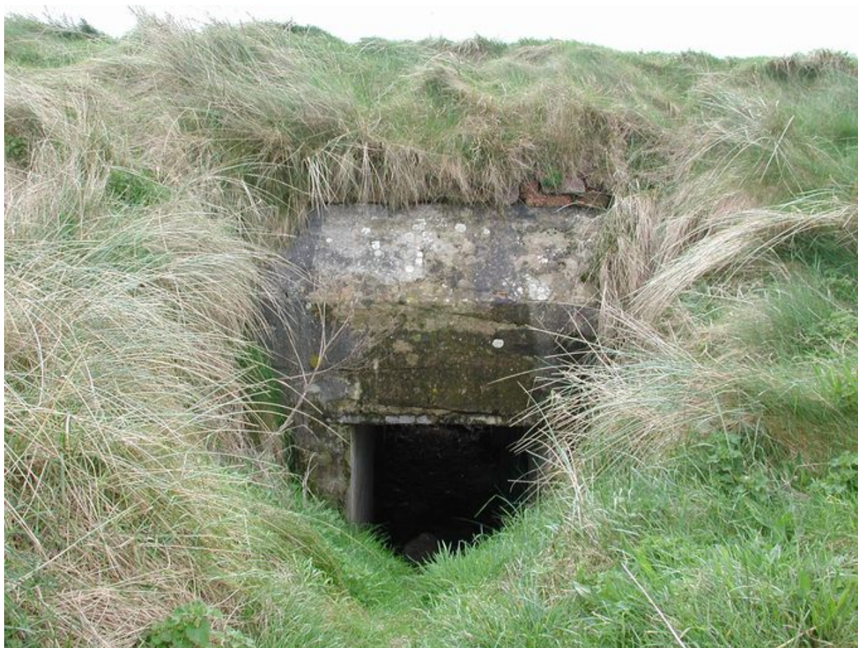
Vue de l'entrée est (état en 2002)
