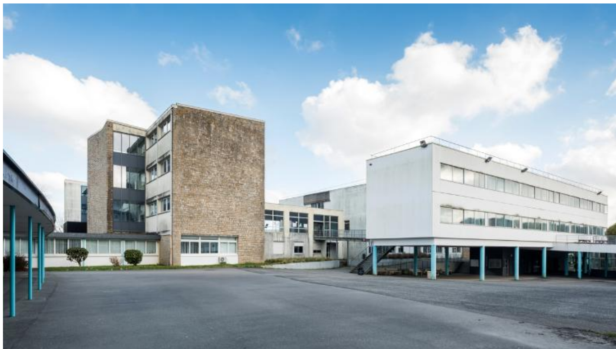
Vue d'ensemble de la cour prise de l'ouest. A droite, façade ouest de l'externat de 2001.
