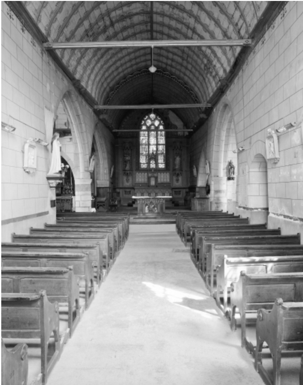
Intérieur : vue générale vers le chœur.
