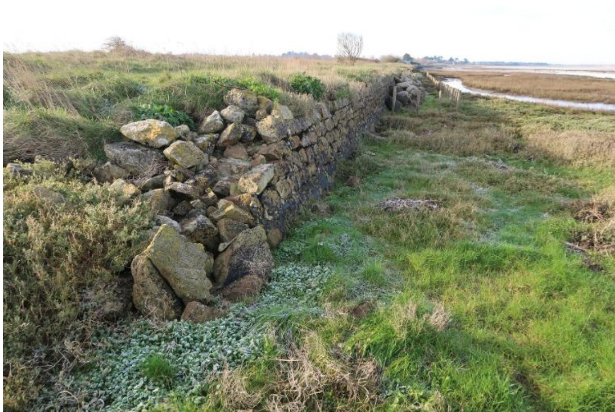
Vue de la digue Michel. Elle est constituée par un mur en pierre sèche
