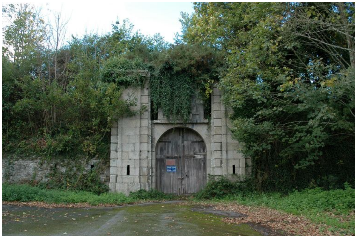
Vue du fort de Penfeld : la porte autrefois précédée d'un pont-levis
