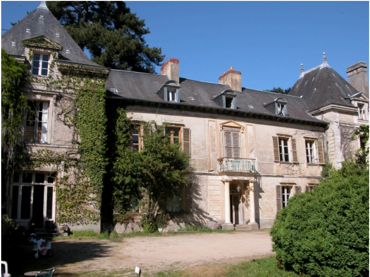
Vue générale sud
