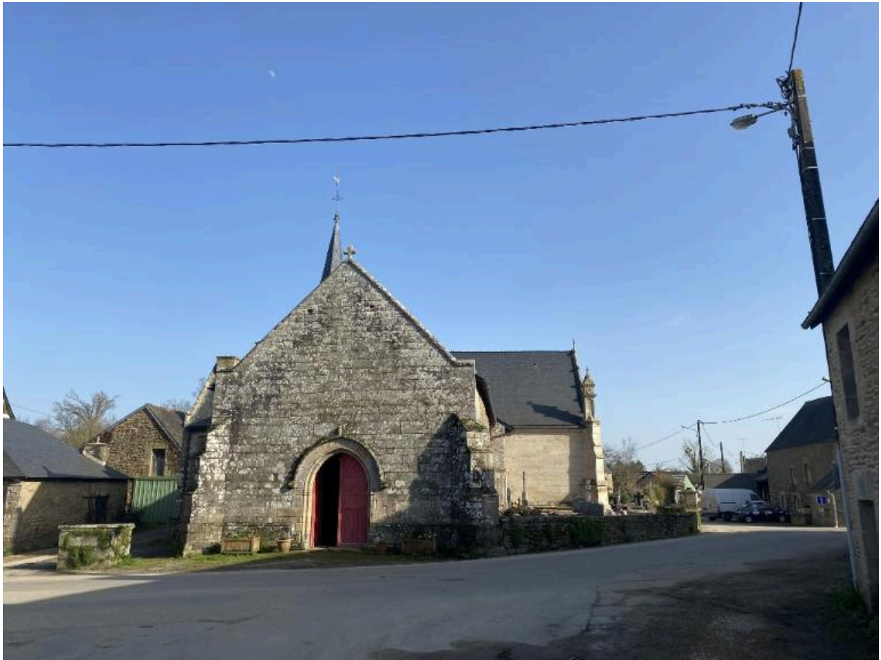
Élévation ouest, vue générale
