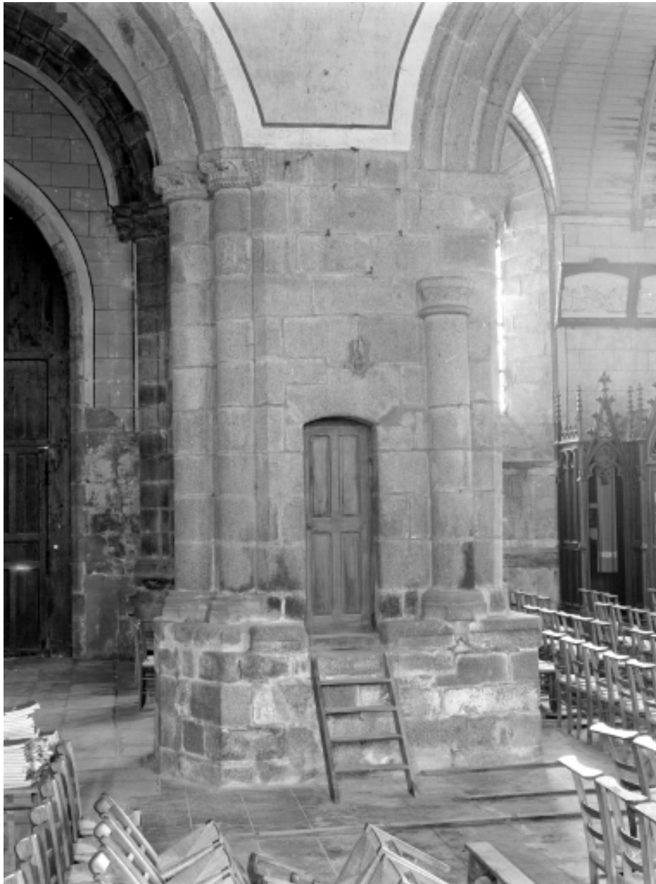
Intérieur, pile 3, côté Sud : vue générale.
