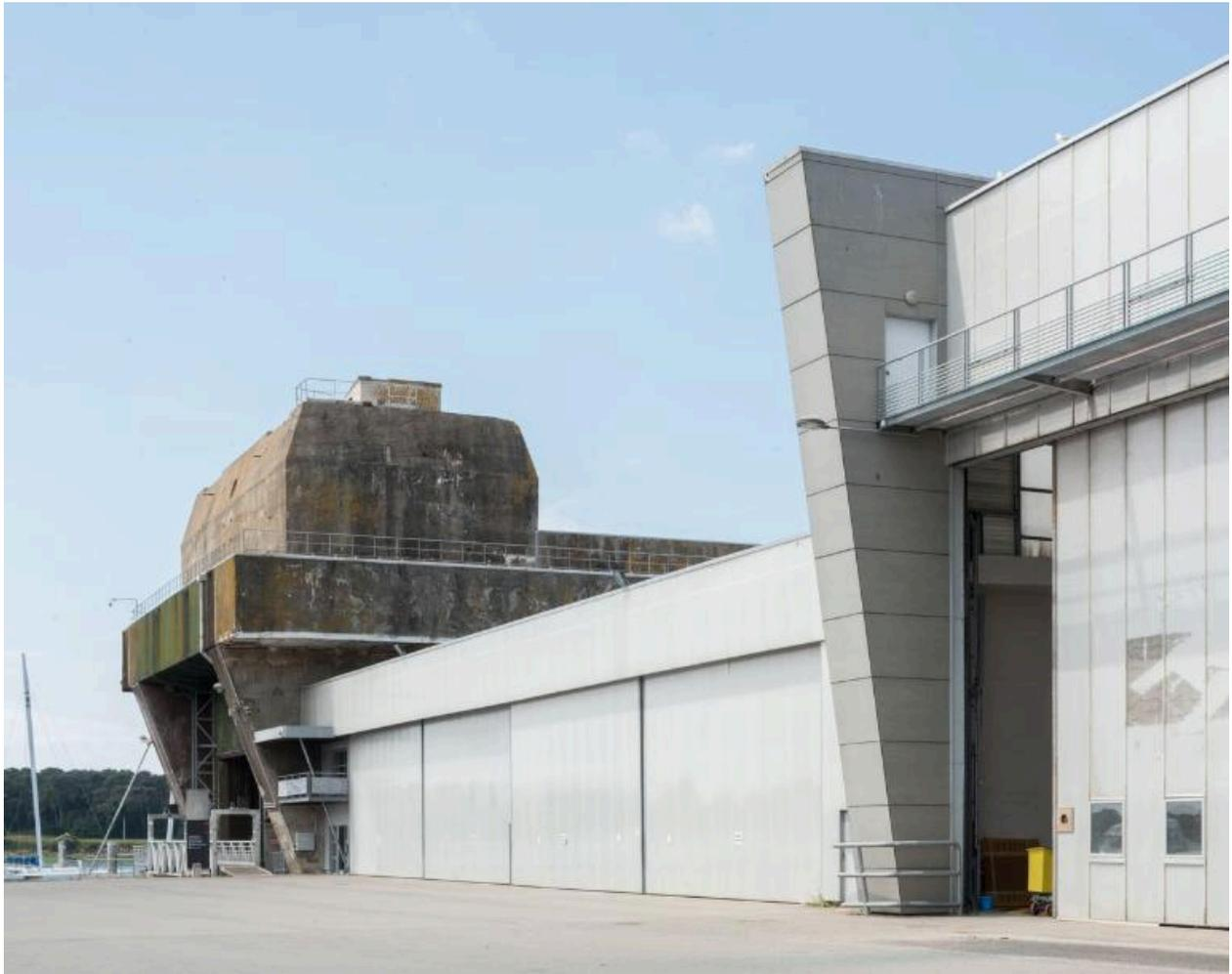
Vue de l'entrée du slipway et des docks reprennant la forme des contreforts en béton armé. L'alvéole du slipway est surmontée d'un envuvement pour un canon antiaérien
