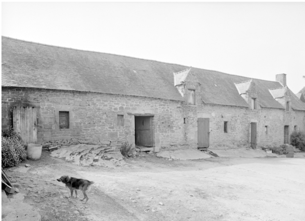
Communs et cour, élévation est.
