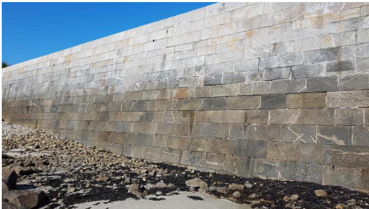
Môle, côté sud, maçonnerie pierres de taille (vue rapprochée)
