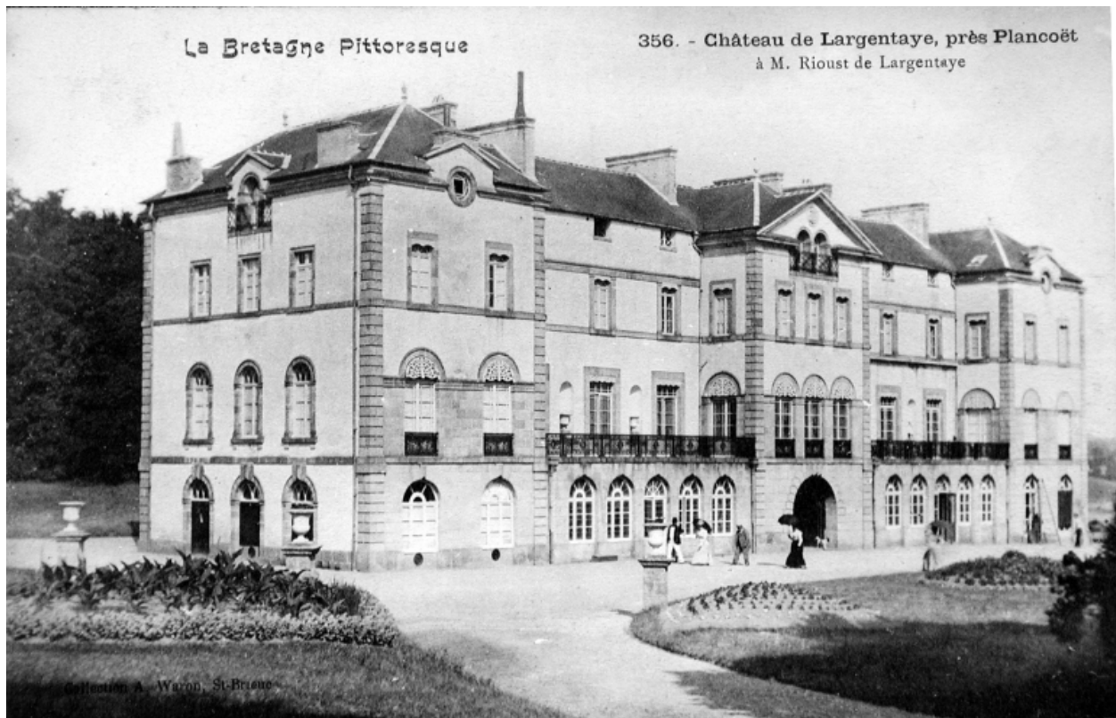
Vue générale de la façade principale
