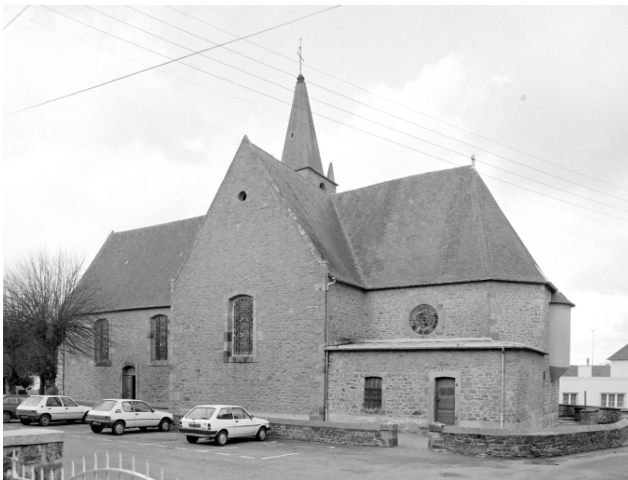
Elévation Sud : vue générale
