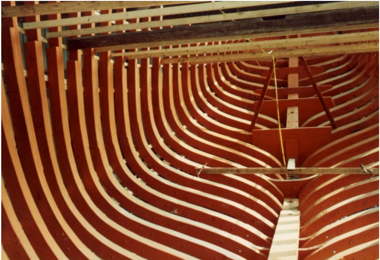
Vue de la charpente intérieure de la coque entièrement membrée et varangée, au chantier Clochet (collection particulière, Association le Grand Léjon)
