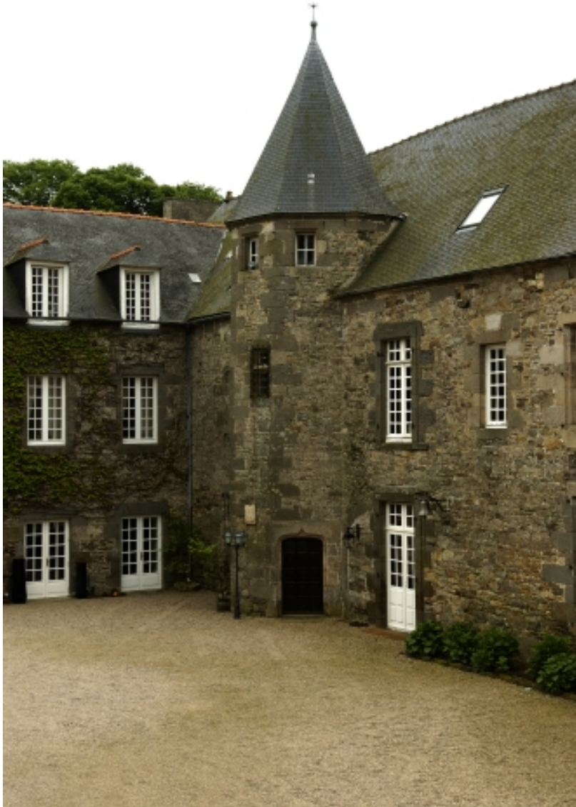
Tour d'escalier ; vue générale nord ouest
