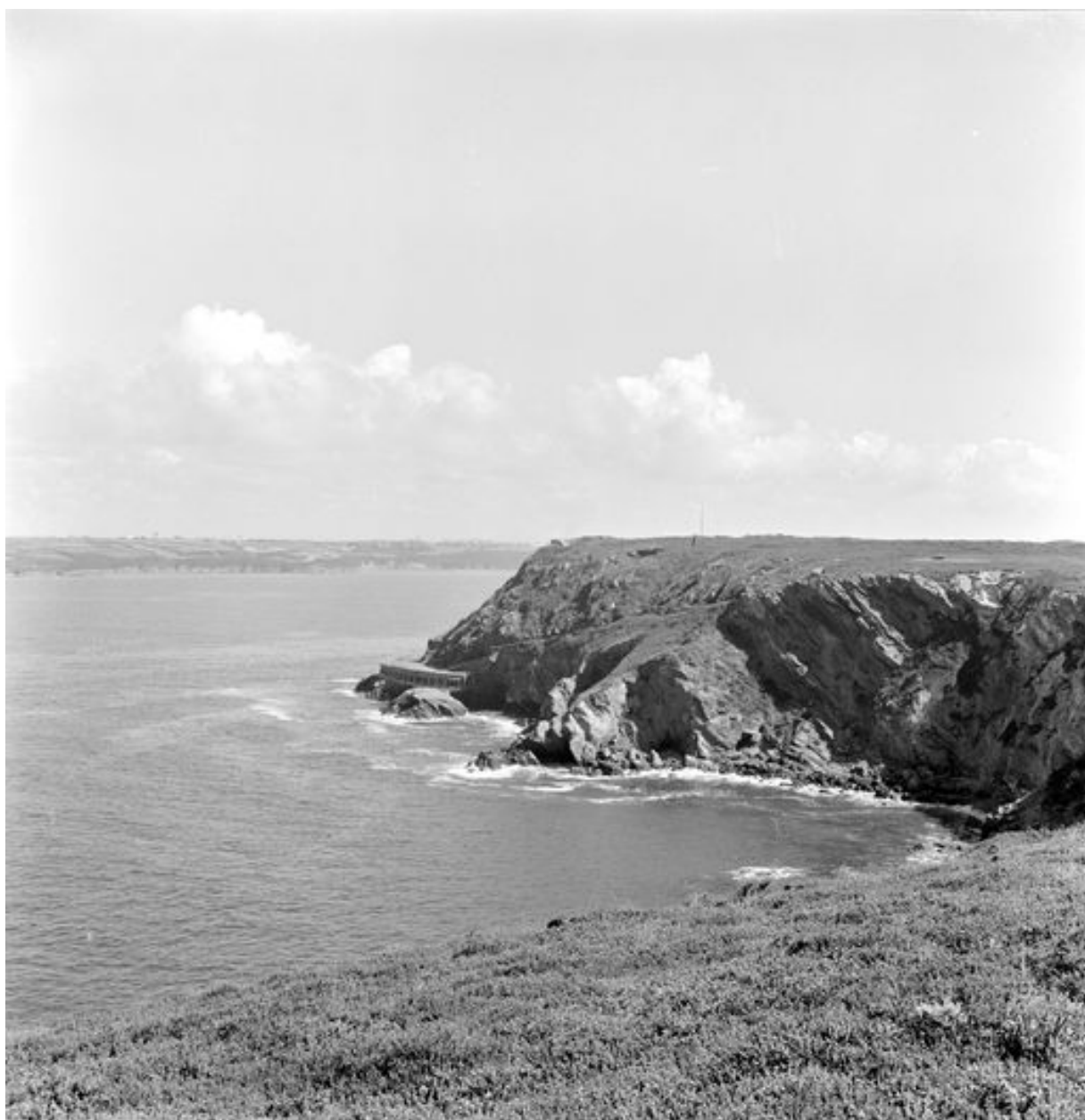
Vue de situation de la batterie de Cornouaille en 1969
