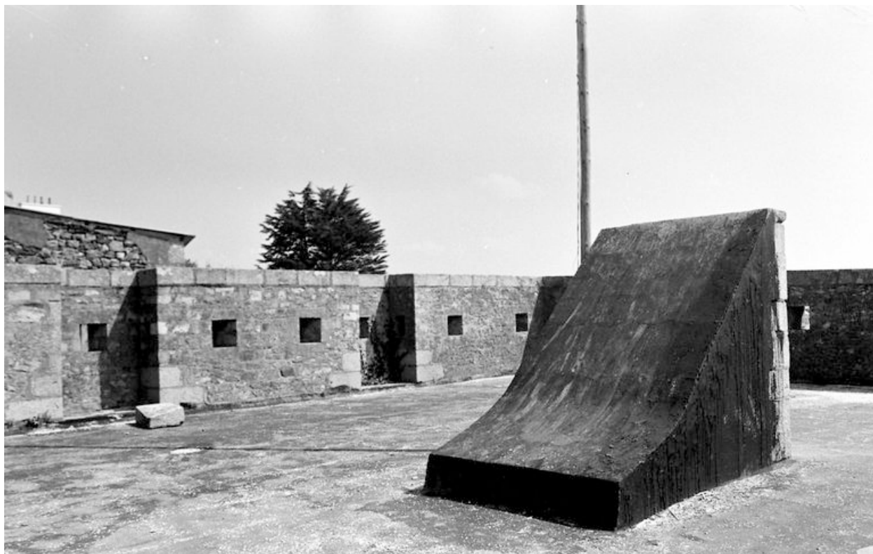
Vue du corps de garde crénelé n° 3 du bourg de Roscanvel en 1969 : terrasse, débouché de l'escalier intérieur
