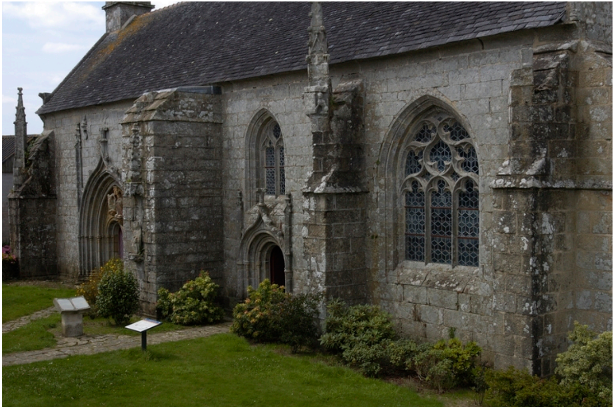
Vue biaisée de l'élévation sud
