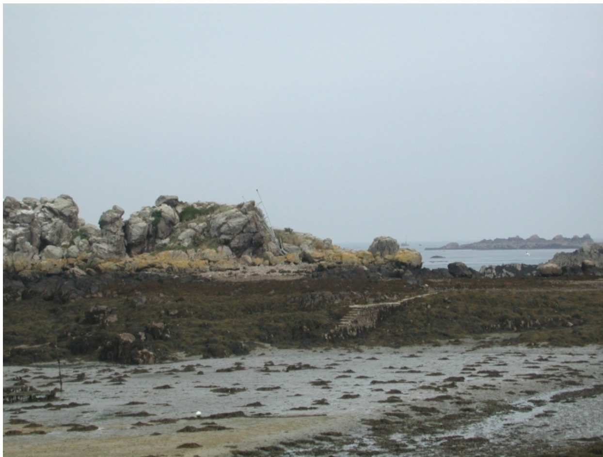
Vue générale de la jetée Ouest
