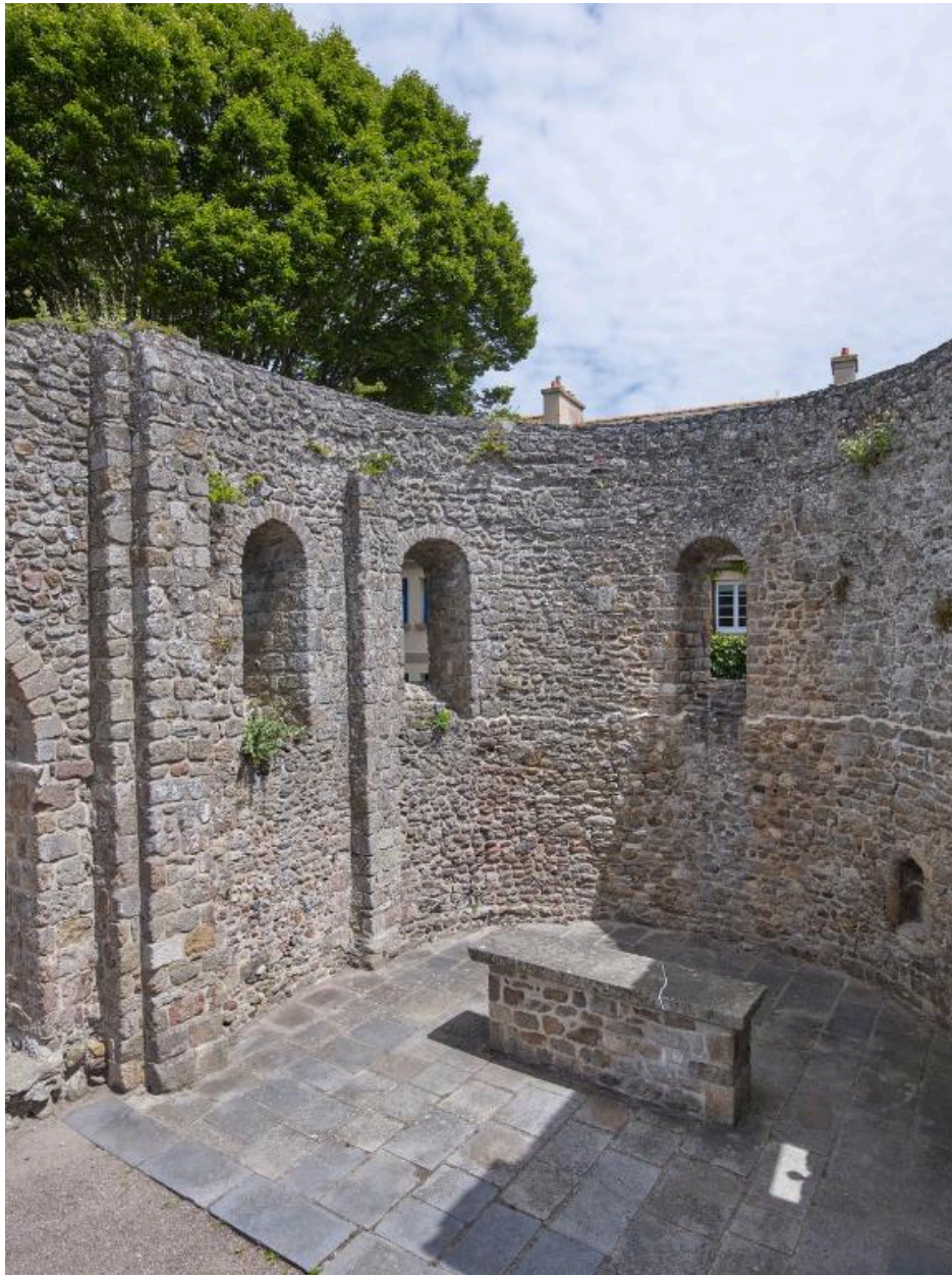
Vue de l'élévation de l'abside orientale
