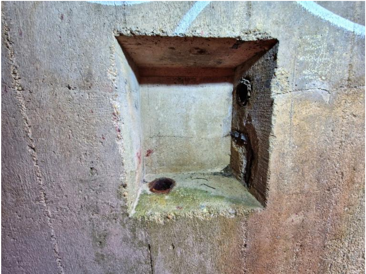
Vue intérieure : niche murale de l'un des deux accès nord
