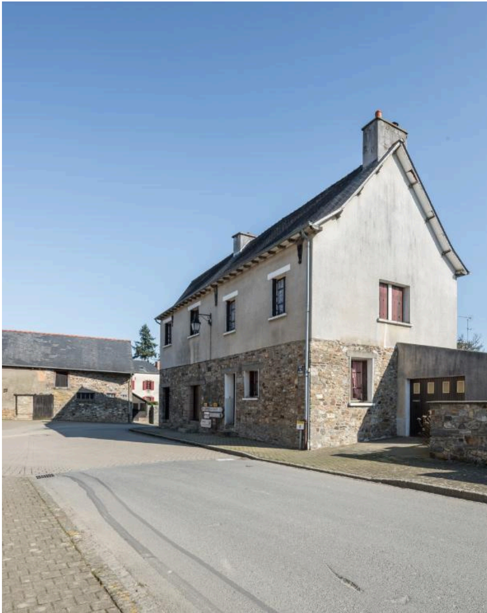
Ancienne auberge "A l'écu de France", façade principale et mur sud
