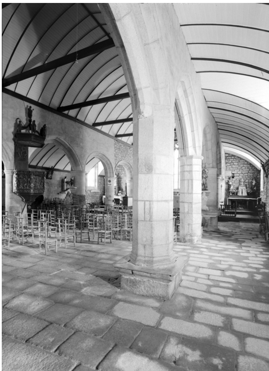
3ème arcade sud de la nef : détail de la pile est
