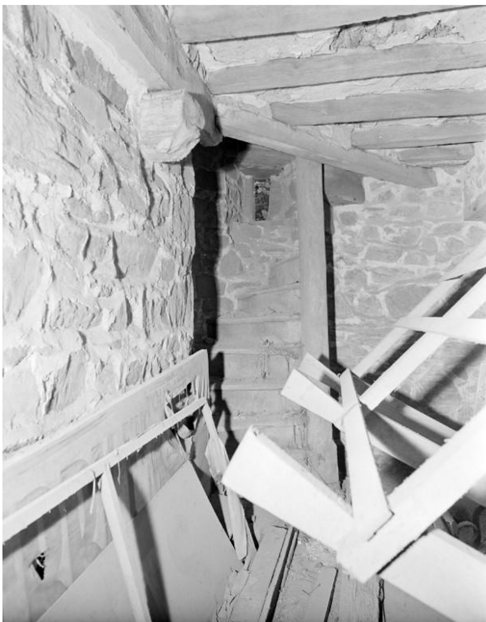
Intérieur, détail : escalier des combles.
