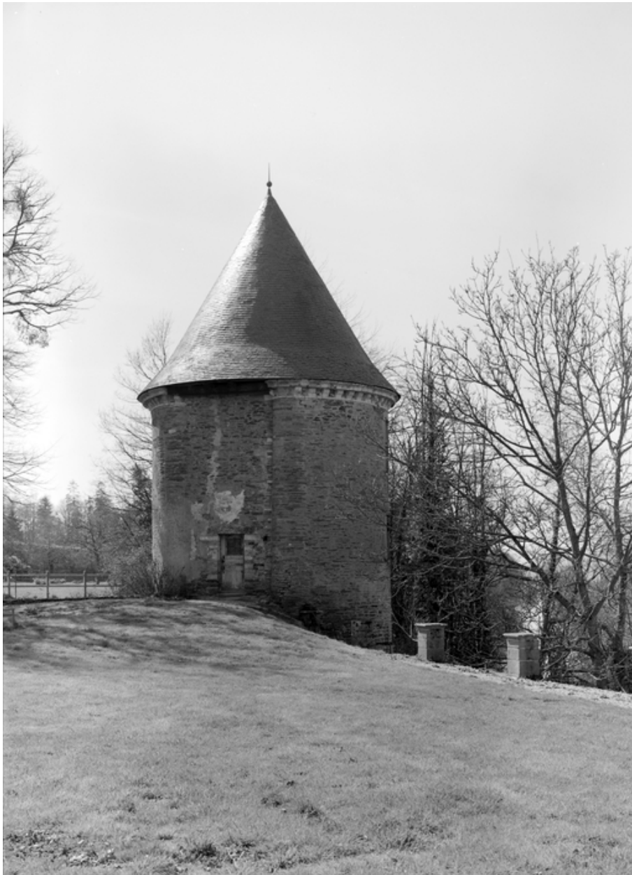
Château : tour isolée nord-ouest vue de l'est (état en 1984)
