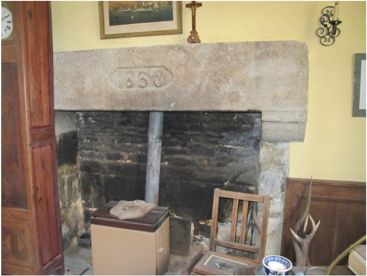
Logis, cheminée du rez-de-chaussée de l'aile arrière
