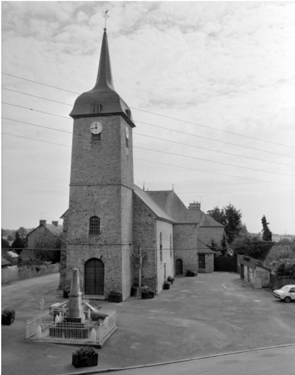
Elévation ouest : vue générale
