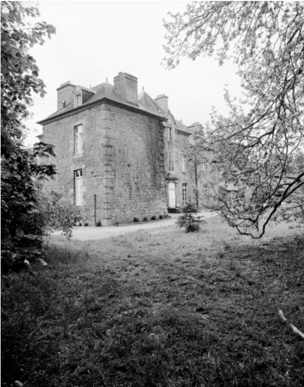
Pavillon est : vue générale du nord-est.
