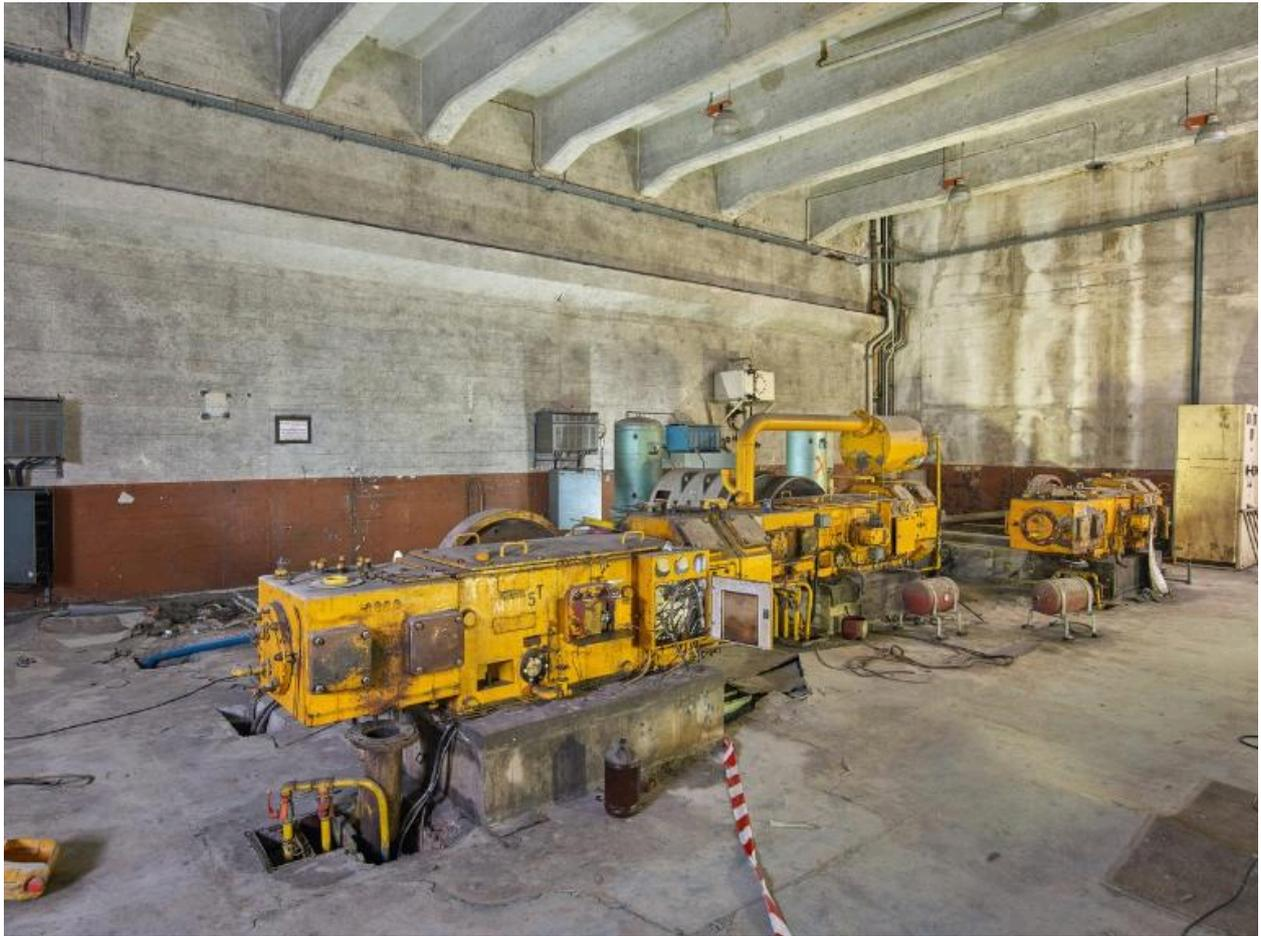
Vue de la salle des groupes électrogènes diesel : ensemble de trois groupes électrogènes alimentant des moteurs asynchrones des Ateliers Bernard Bonfond Saint-Étienne
