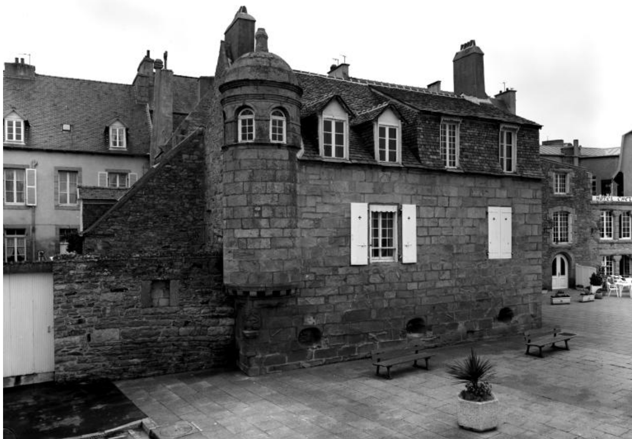
Vue générale : élévation est sur le port de Roscoff (état en 1985)
