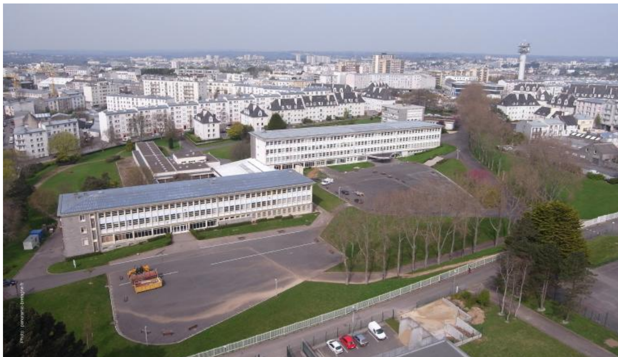
Vue aérienne oblique de l'ensemble de la cité scolaire, prise de l'est vers l'ouest.
