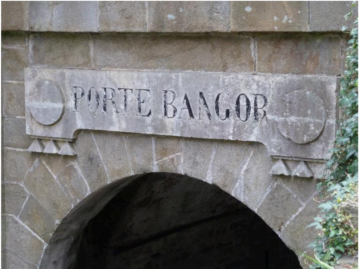
Le Palais, enceinte urbaine, porte de Bangor, débouché côté campagne, détail.
