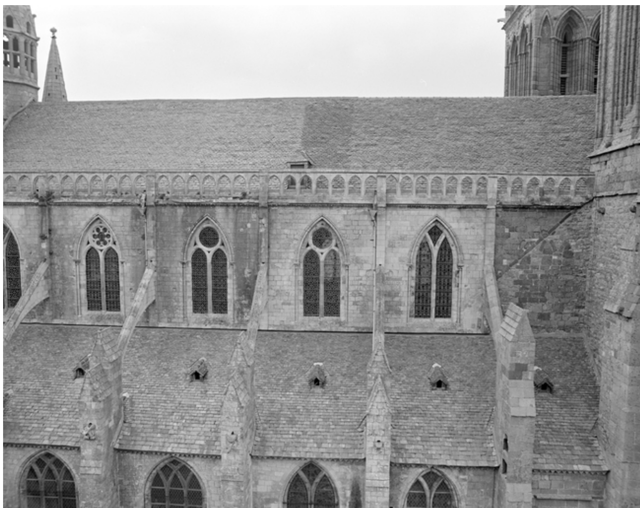
Mur nord, détail contrefort
