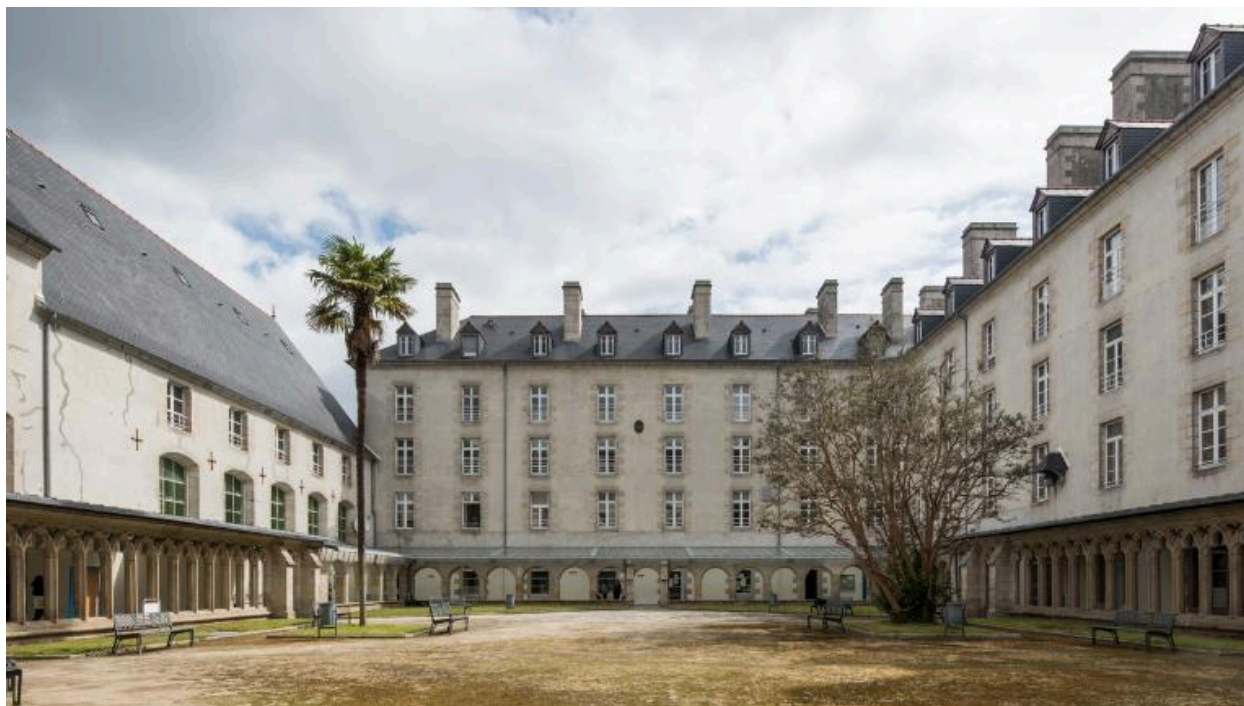
Bâtiments de l'ancien séminaire, vue d'ensemble de la cour vers l'aile nord-est. A gauche la chapelle des Sœurs du Calvaire (1663).
